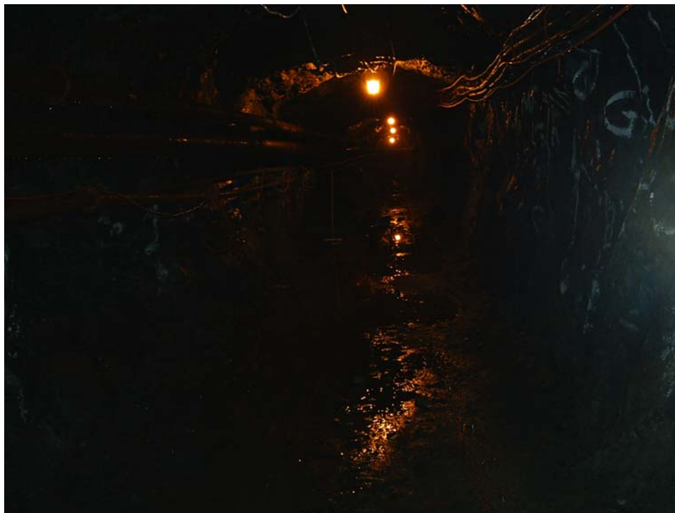
Figure 2.10 Photo de la galerie souterraine utilisée pour les mesures
